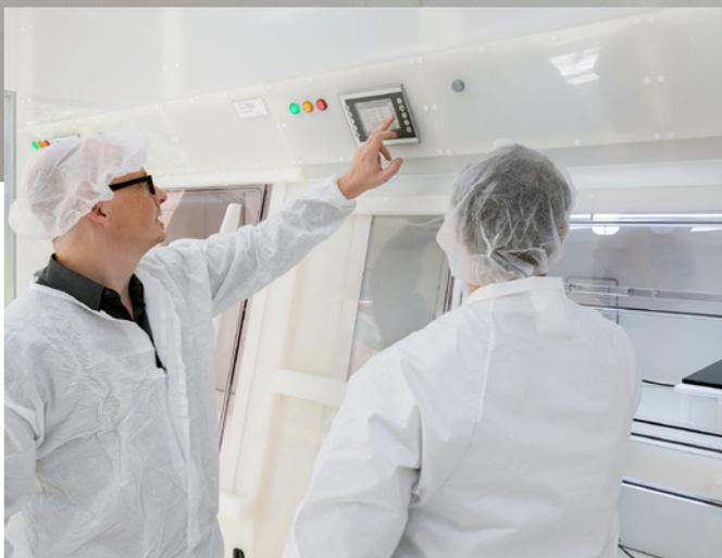
Über integrierte Touch-Displays wird die Lüftungs- und Versorgungstechnik an den Arbeitsplätzen individuell gesteuert.
