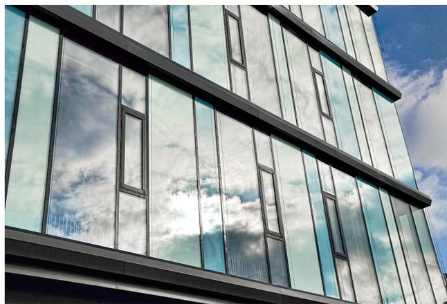
**Teilansicht Fassade:** Fenstergläser und lackierte Gläser mit innenseitiger Verblechung wechseln sich ab. Die Fassade wirkt gläsern, ist aber zu 50 Prozent mit geschlossenen Paneelen belegt.
