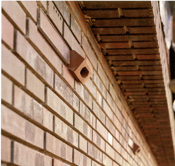
Klinkerfassade des Depotbereichs mit plastischer Tiefenwirkung und Bezug zur industriellen Bautradition des Standorts.
